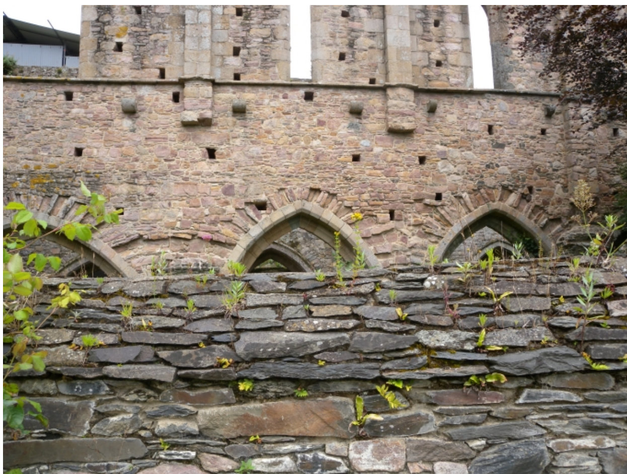
Vue de détail du mur d'enceinte Nord, restauré, construit en moellons de schiste
