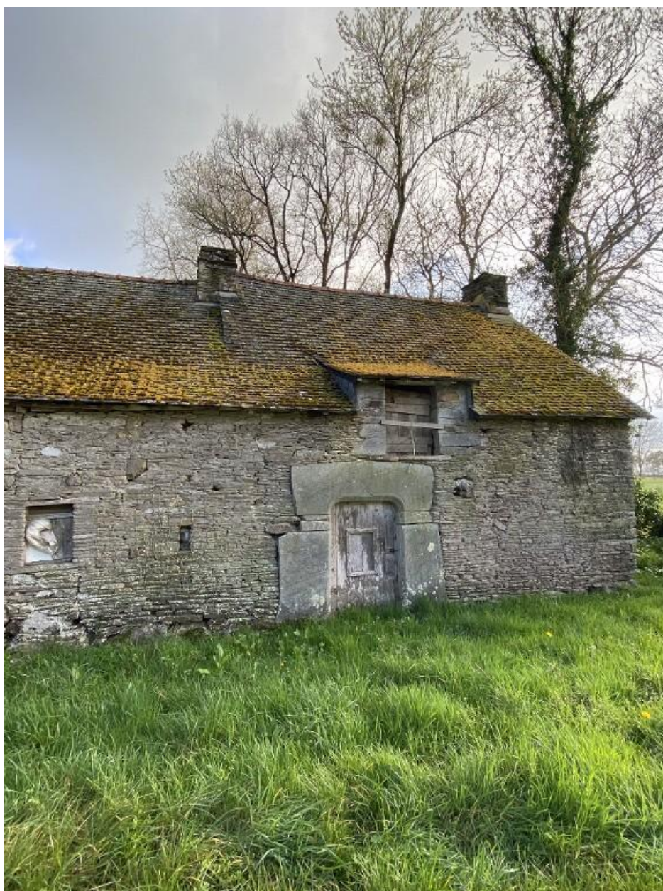
Vue générale, élévation nord-est. (état en mars 2025)
