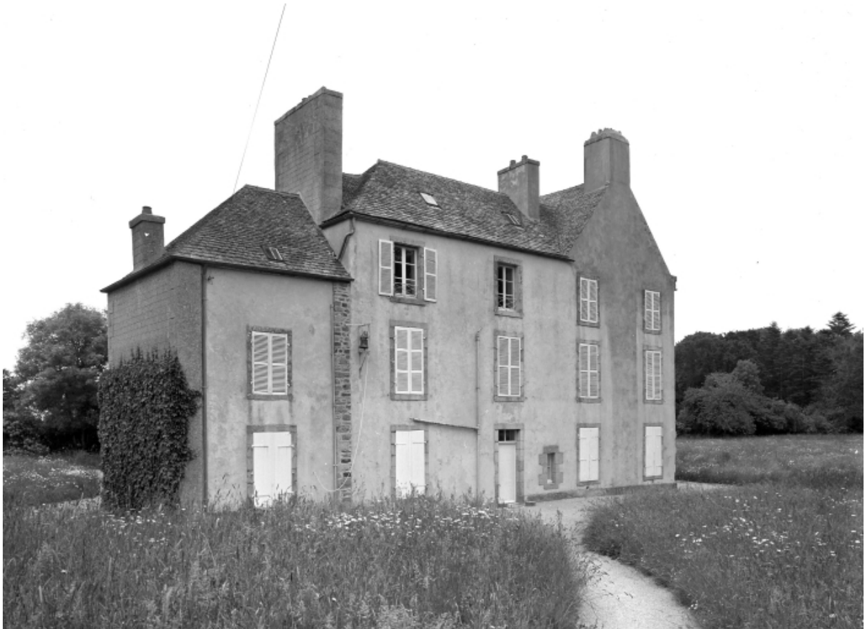
Logis, élévation sud, vue générale
