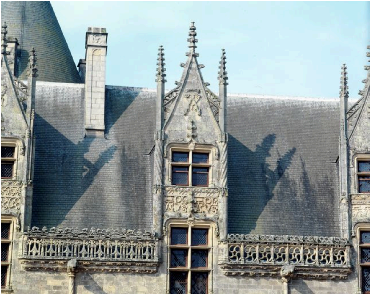
Logis, élévation sur cour : 7e lucarne à partir du sud
