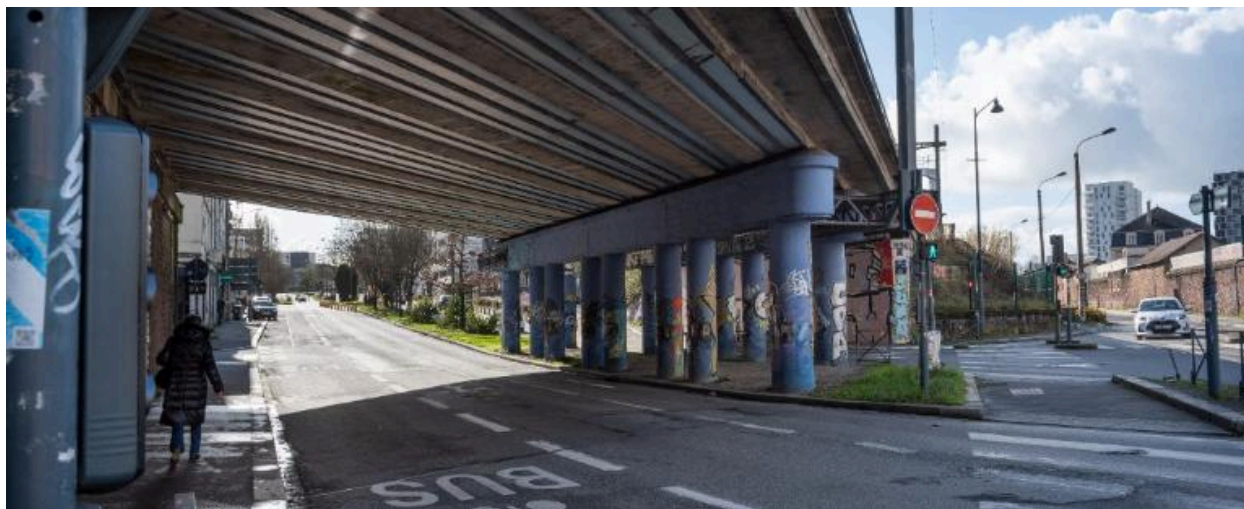
Vue de la structure porteuse du pont de Nantes.
