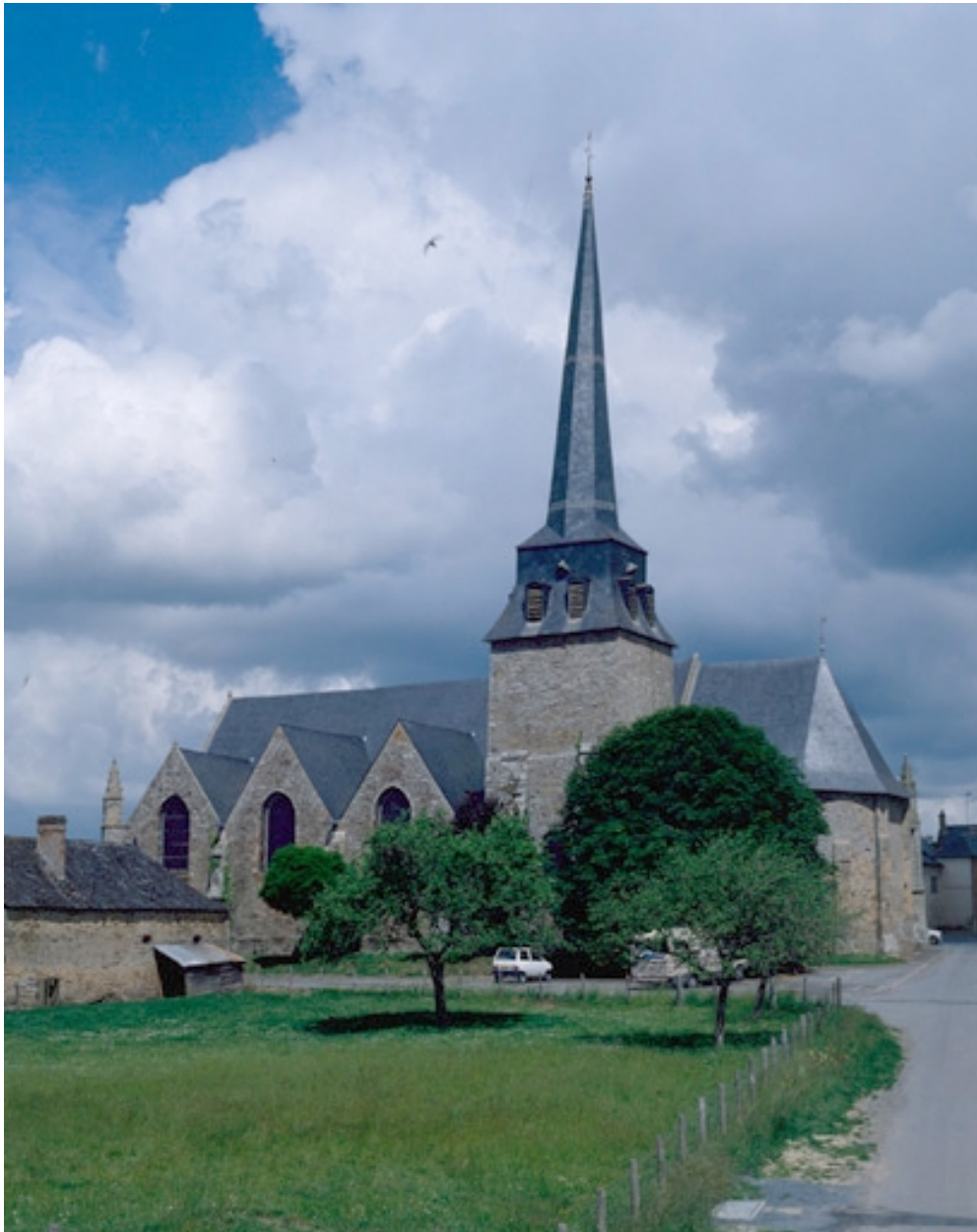
Vue générale de la façade sud
