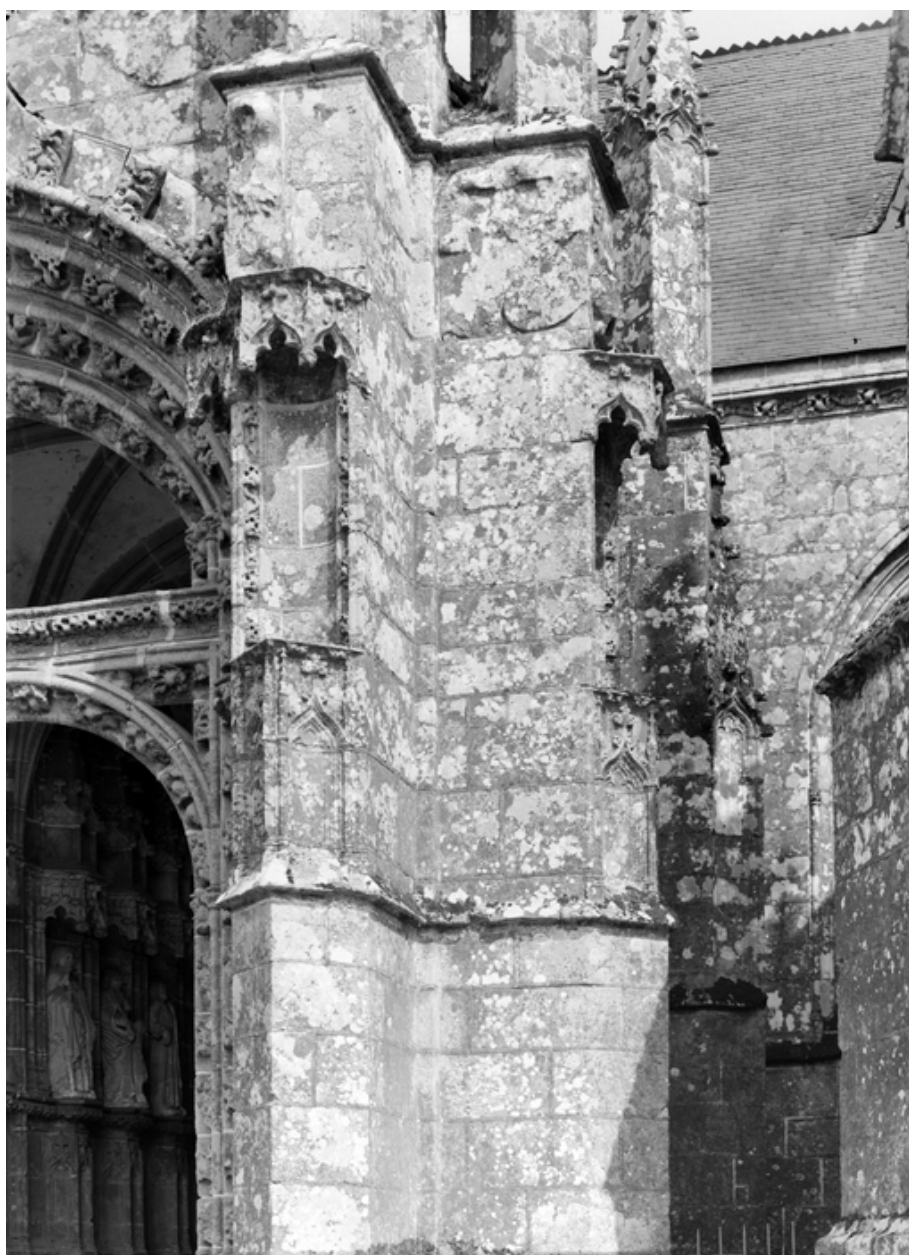
Niches extérieures du porche de la nef.
