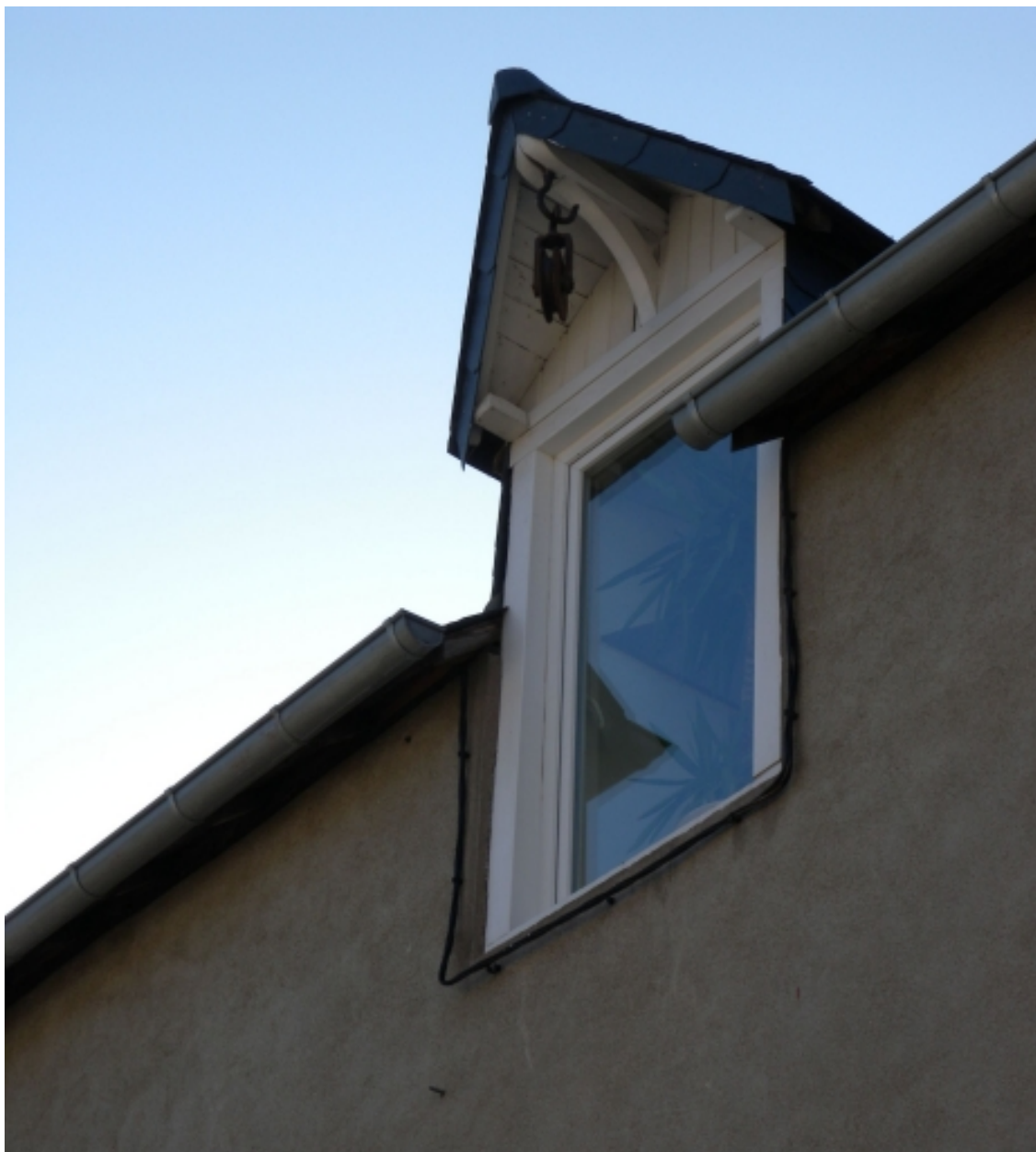
Vue d'une ancienne lucarne sous combles avec le palan
