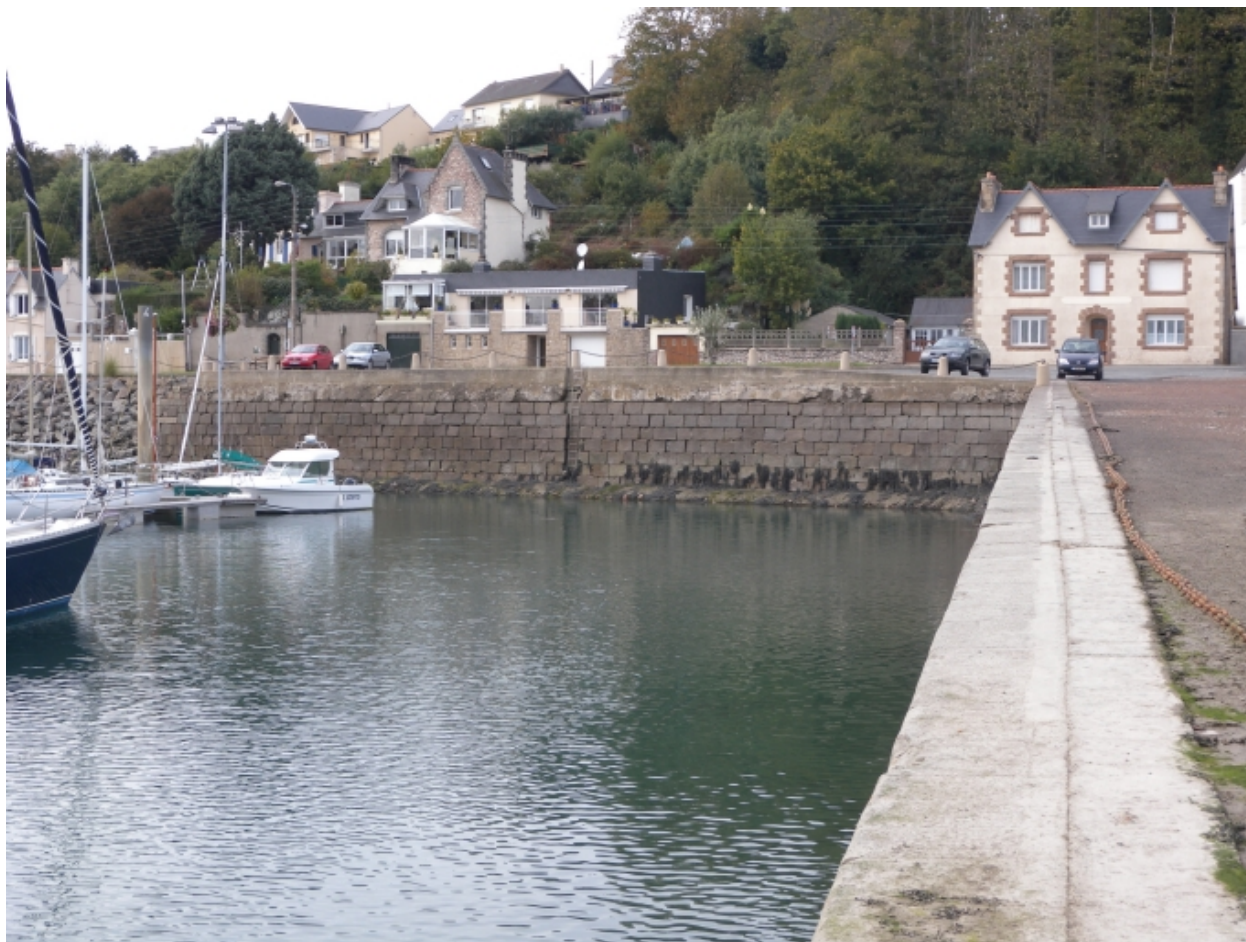
Vue générale des anciens quais en pierre de taille perpendiculaires à la nouvelle cale
