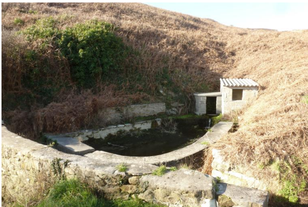
Lavoir dit "prat feunteun vad" au sud-ouest de Lescoff, vue générale prise du sud. Porte la date de 1949.
