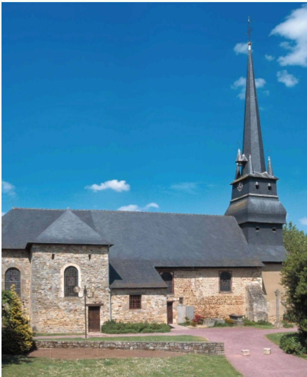
Vue générale de la façade sud
