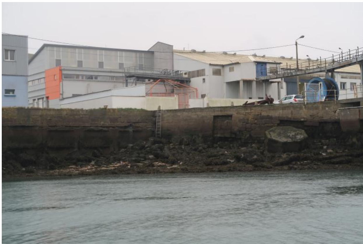
Locaux de Orange-Marine à proximité du poste câblé
