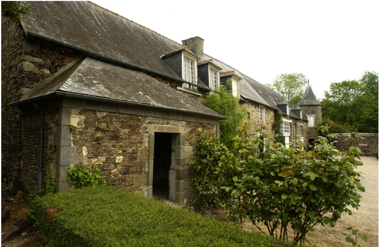
Communs ; vue générale sud ouest
