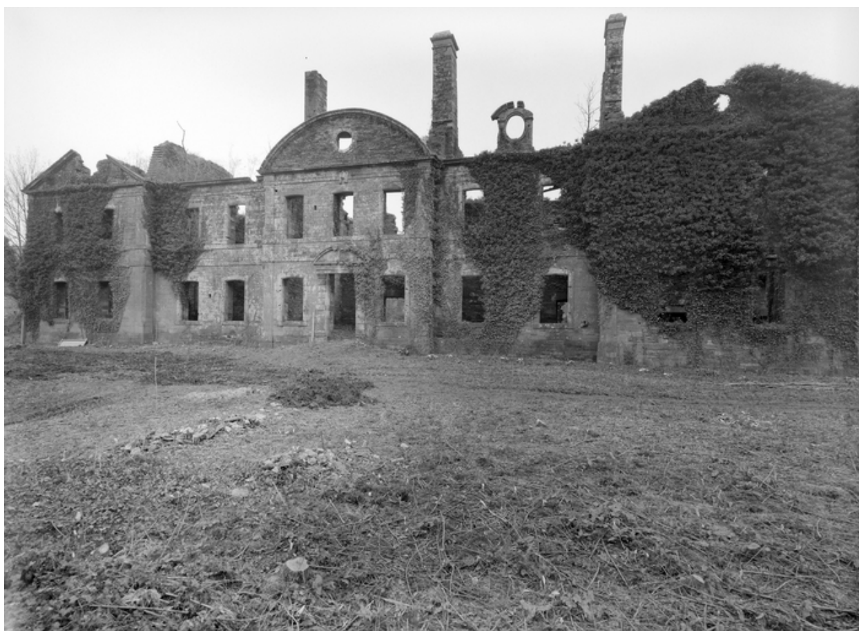
Logis abbatial, élévation Ouest, vue générale (état en 1977).
