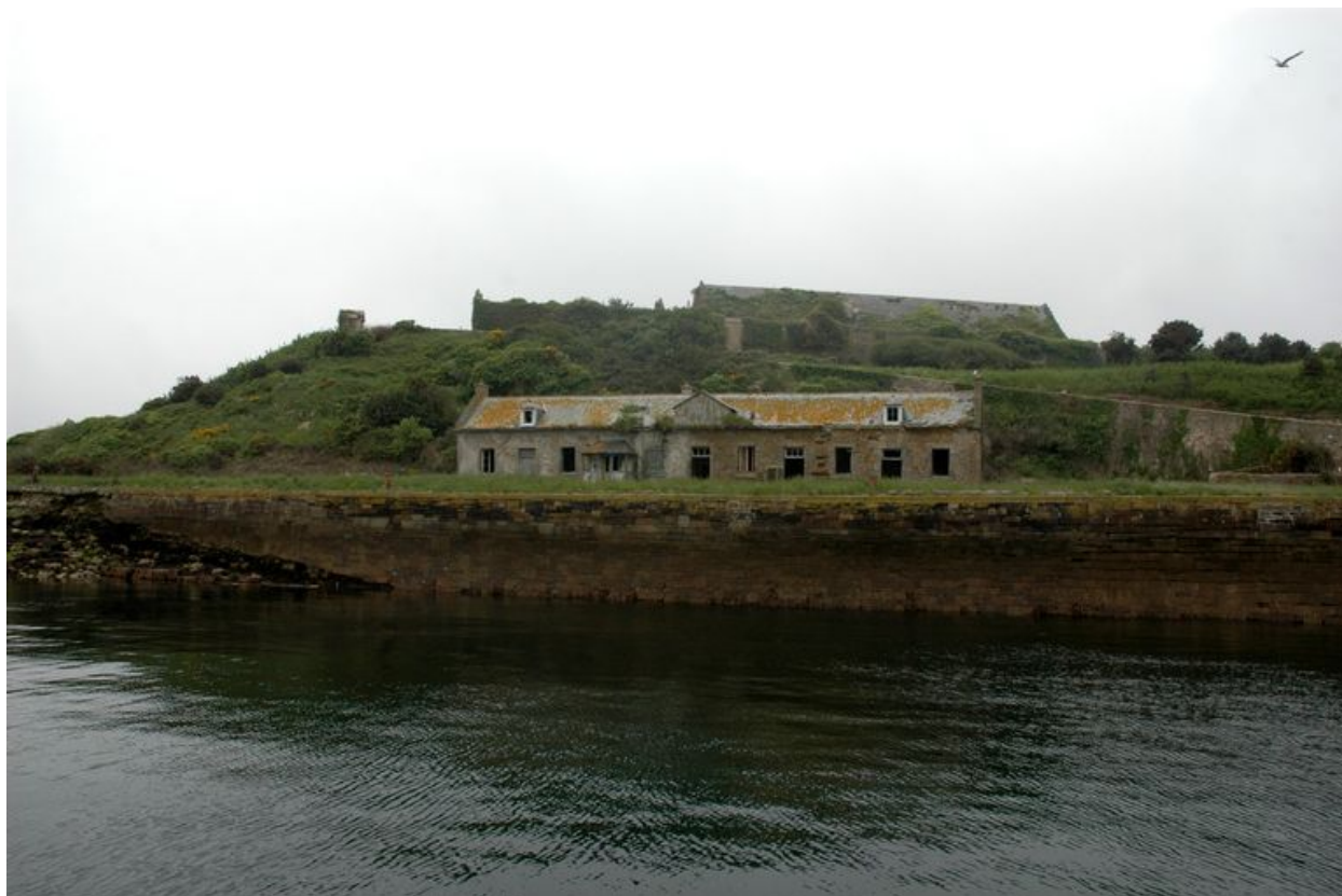
Crozon : vue de l'île des Morts, ensemble de trois magasins à poudre et d'édifices logistiques, caserne
