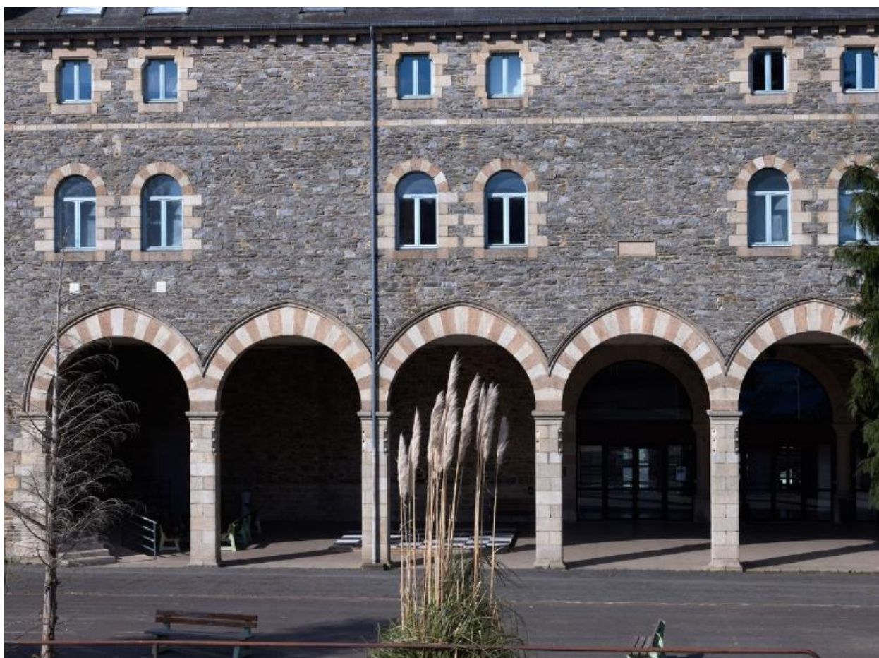
Tréguier : petit séminaire actuellement lycée Joseph Savina, aile nord comprenant le préau avec ses arcades
