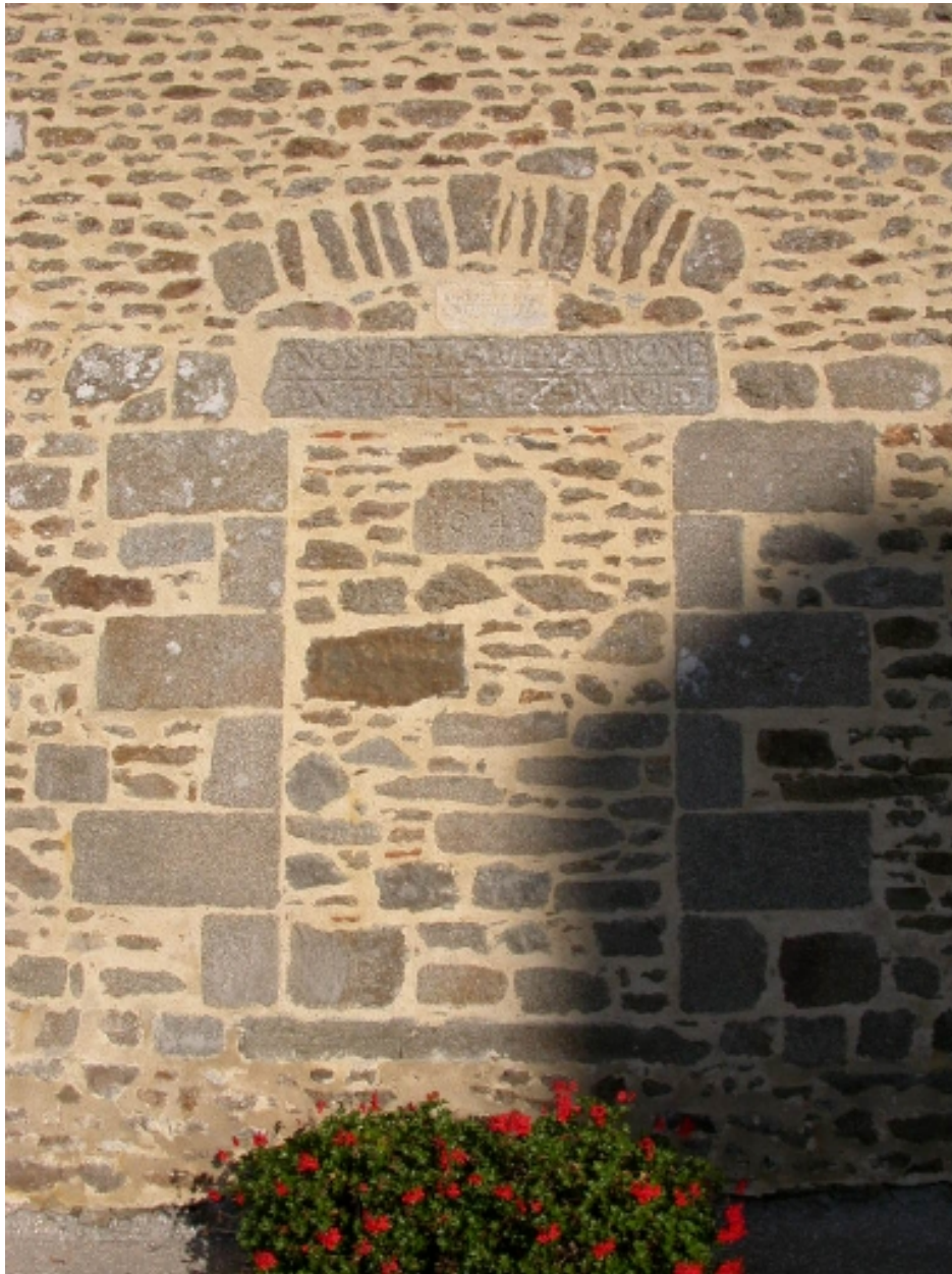
Baie murée de la façade sud
