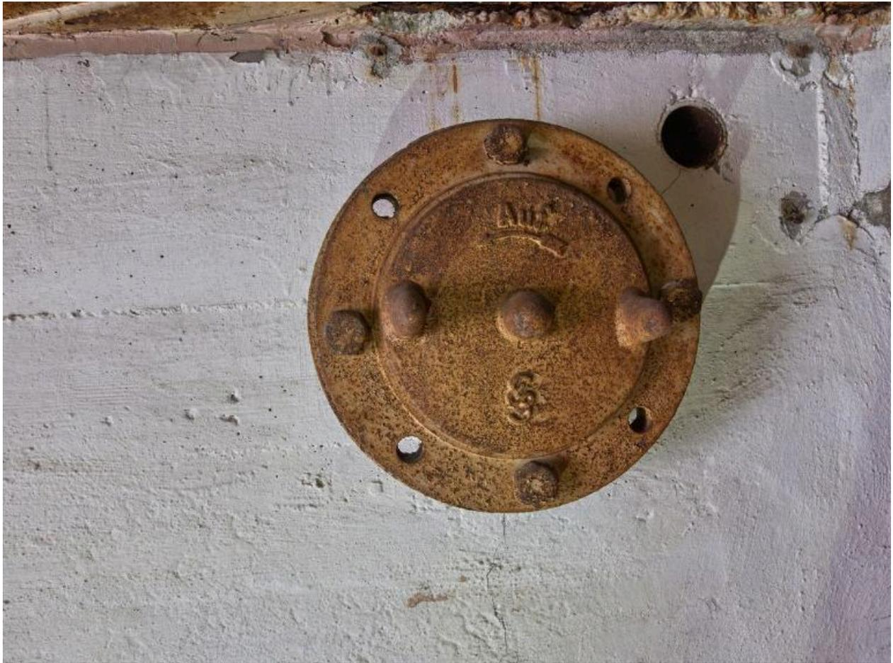
Vue d'une bouche de soufflage à vis réglable en métal frappée du logo de la marque Siemens-Schuckert (Lüftungsventil mit Flanschanschluss, modèle ZML01, à huit boulons). Son marquage Aus, dehors est doublé d'une flèche vers la gauche
