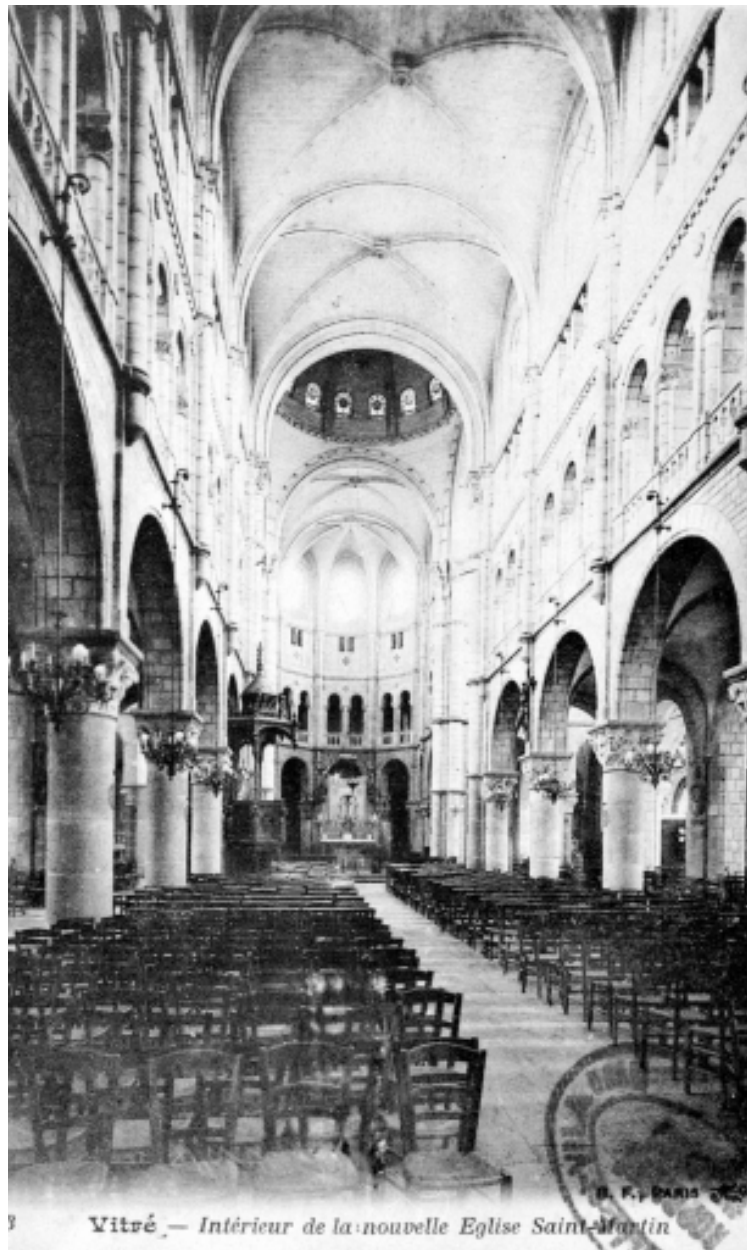
Intérieur : vue générale vers le chœur (Carte postale ancienne, AD35 : 6Fi)
