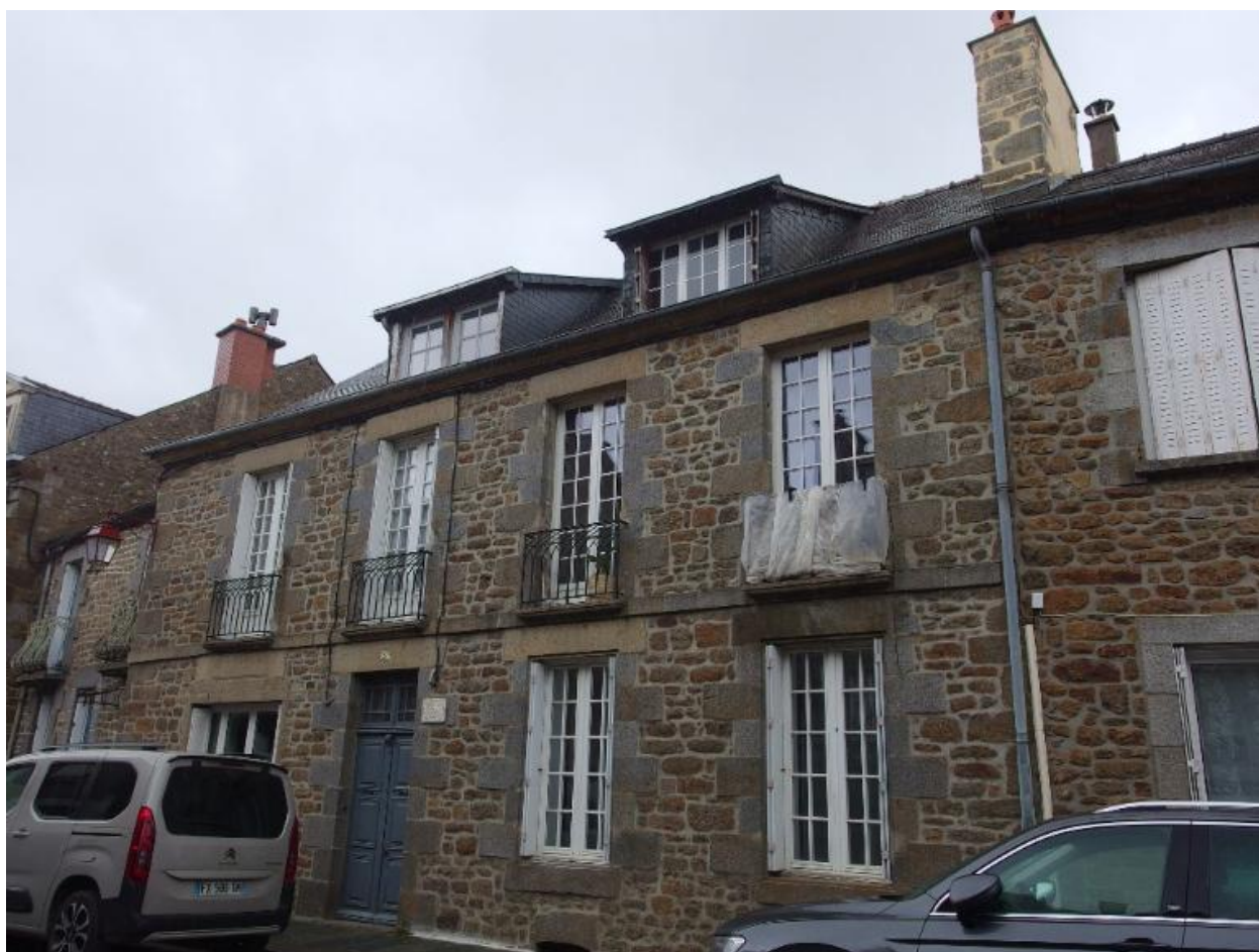
Vue de la façade ouest
