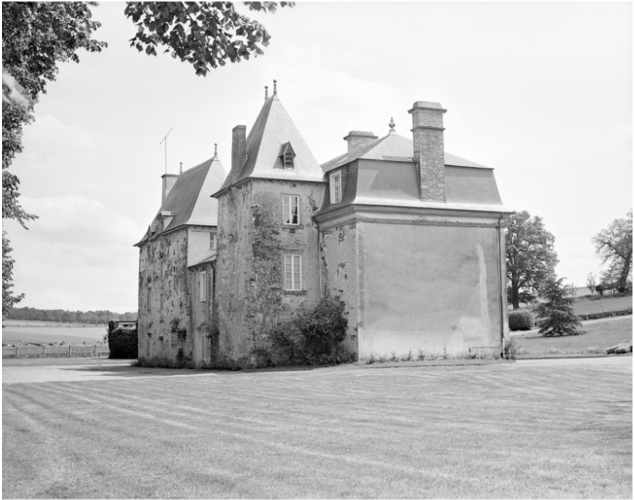
Vue générale sud-ouest de l'élévation postérieure.
