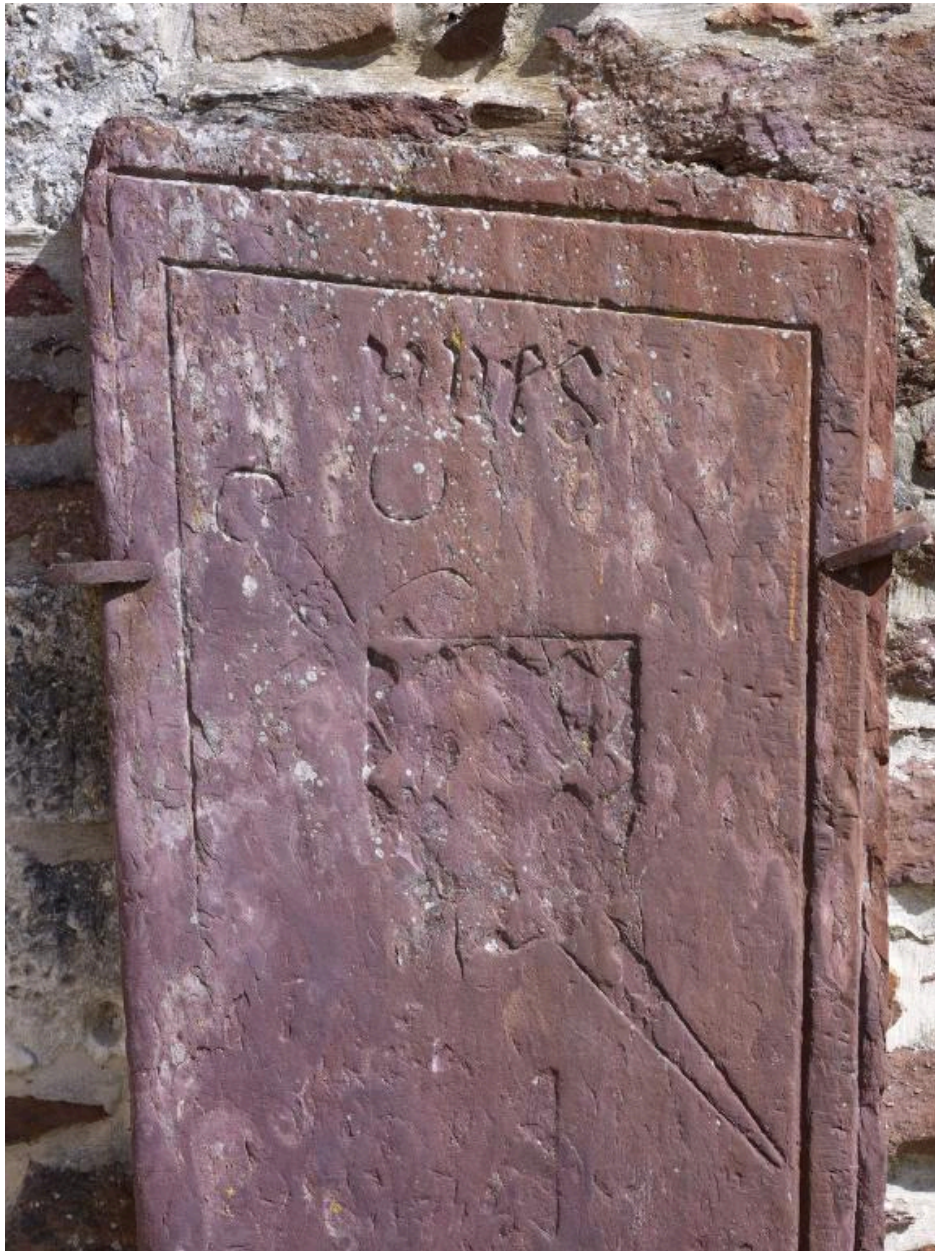
Elévation sud : détail de la pierre tombale
