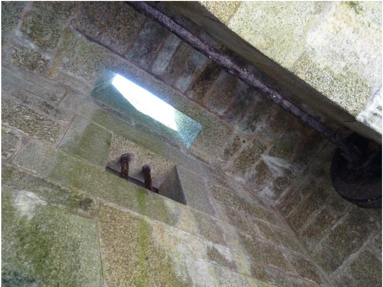
Archipel de Glénan, batterie de Penfret, corps de garde crénelé, créneau de tir au-dessus de l'entrée.
