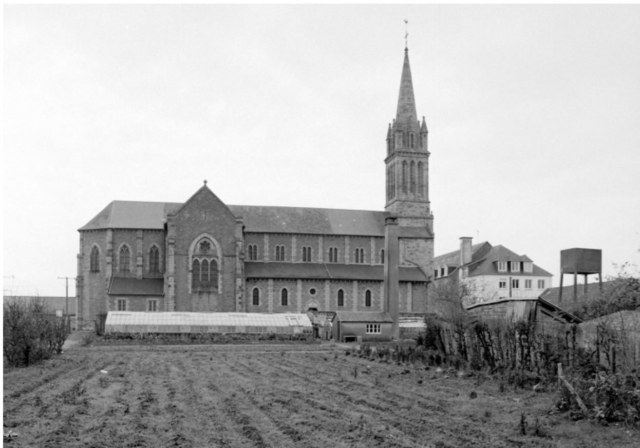
Elévation Sud-Ouest : vue générale
