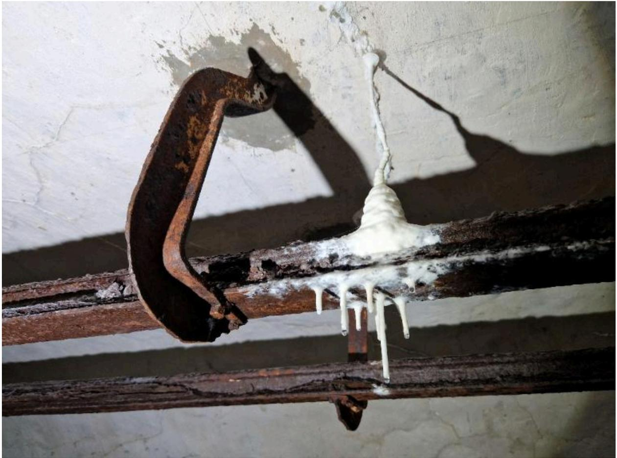
Vue intérieure du magasin à munitions : détail des fixations et rail pour la manutention des obus via un palan
