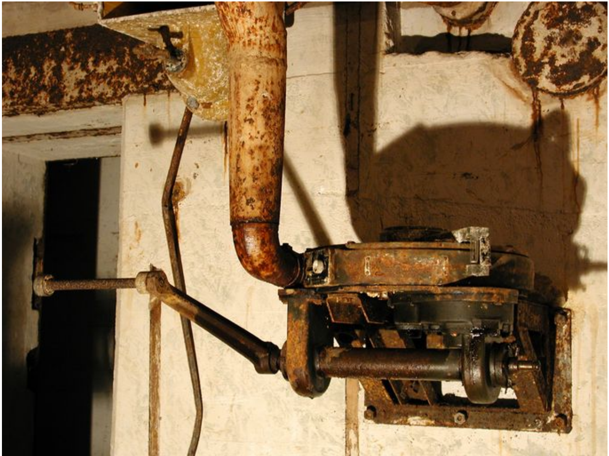
Vue du ventilateur (modèle HES de 2,4 m3 pouvant fonctionner avec deux manivelles)
