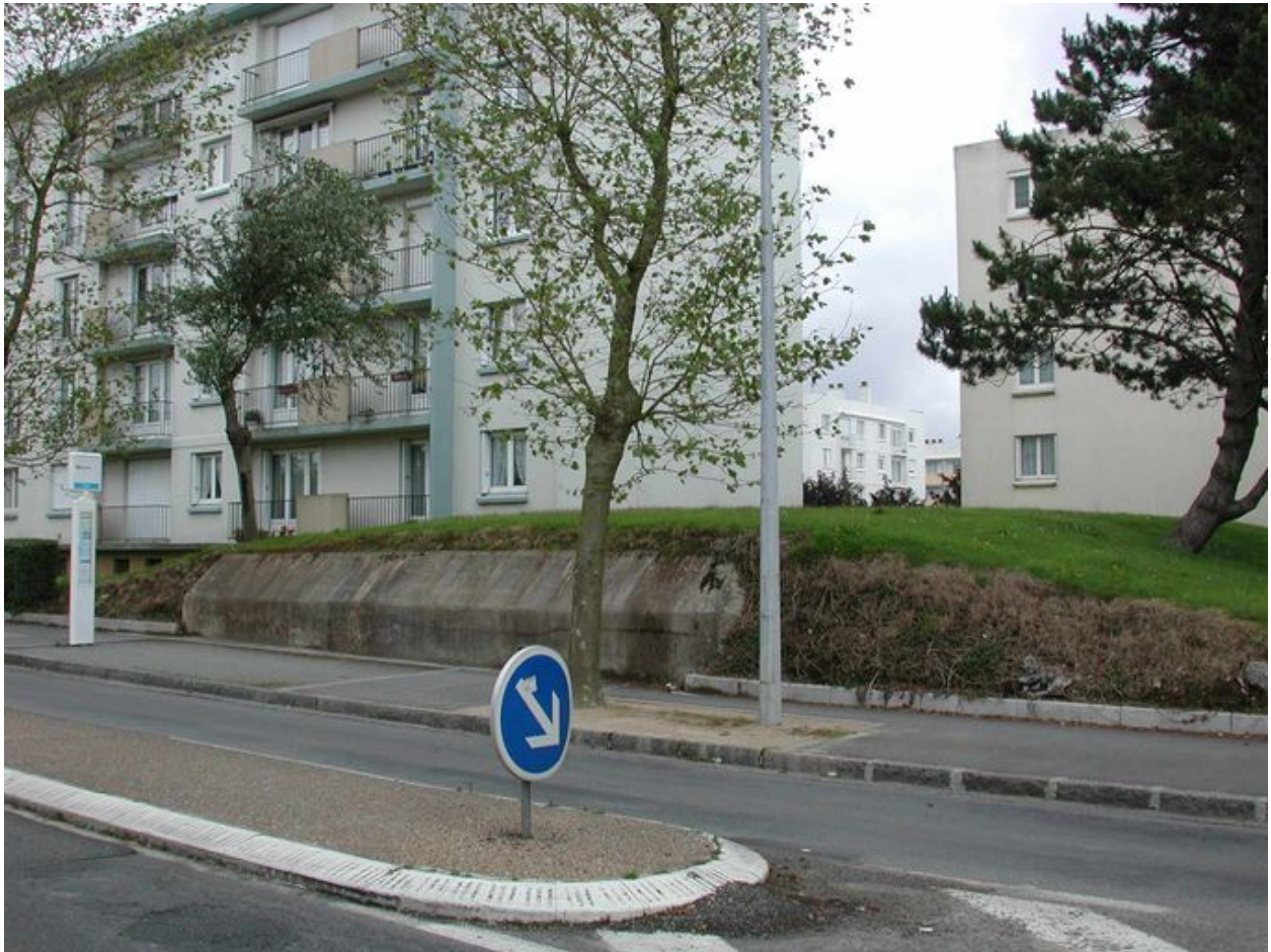
Vue de situation depuis la rue (état en 2002)
