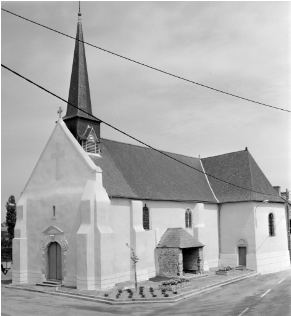
Elévation sud-ouest : vue générale
