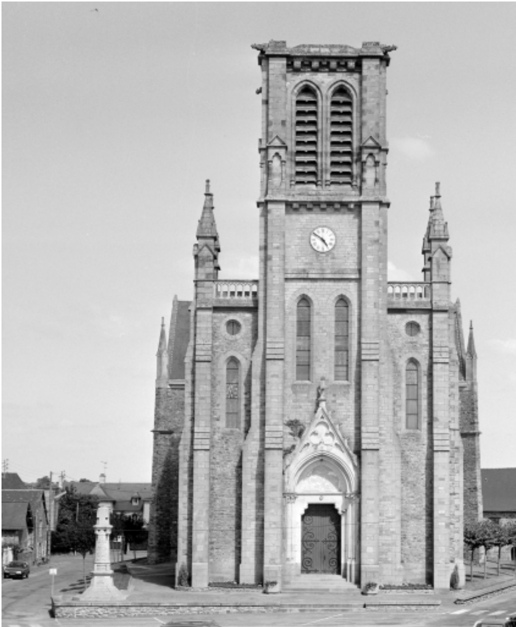
Elévation ouest : vue générale.
