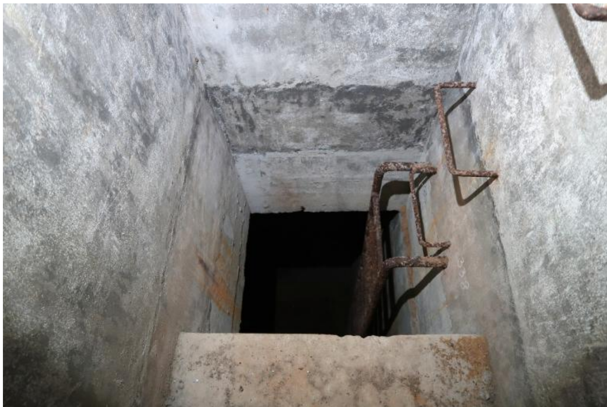
Vue de l'extension nord-ouest : rez-de-chaussée, puits d'accès aux réservoirs situés au sous-sol
