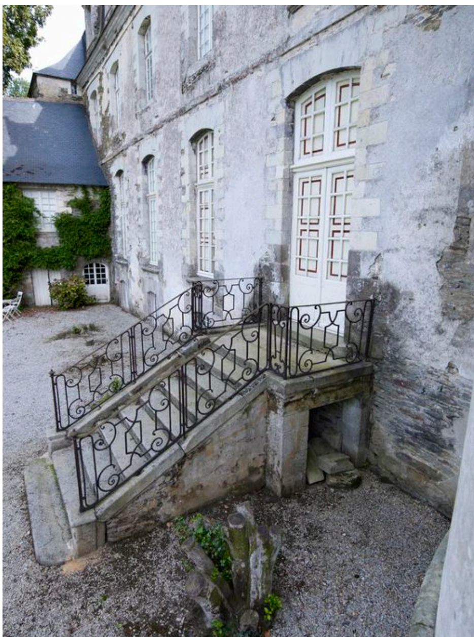
Château, logis, élévation nord : l'escalier (état en 2010)
