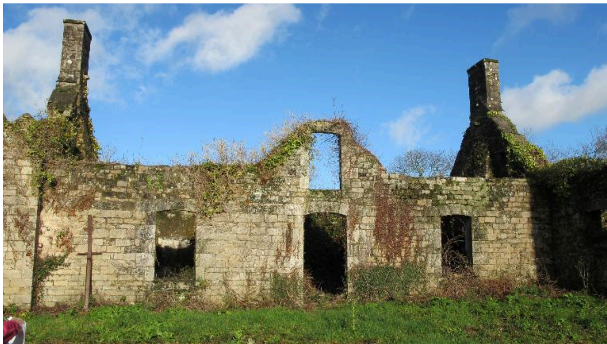
Ferme modèle, logis, élévaton sud, état en 2015
