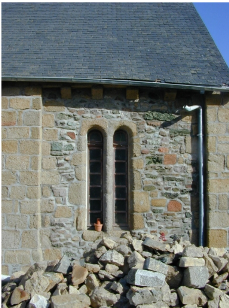
Vue latérale Sud de l'abbatiale, en cours de restauration en 2004 (SRA)
