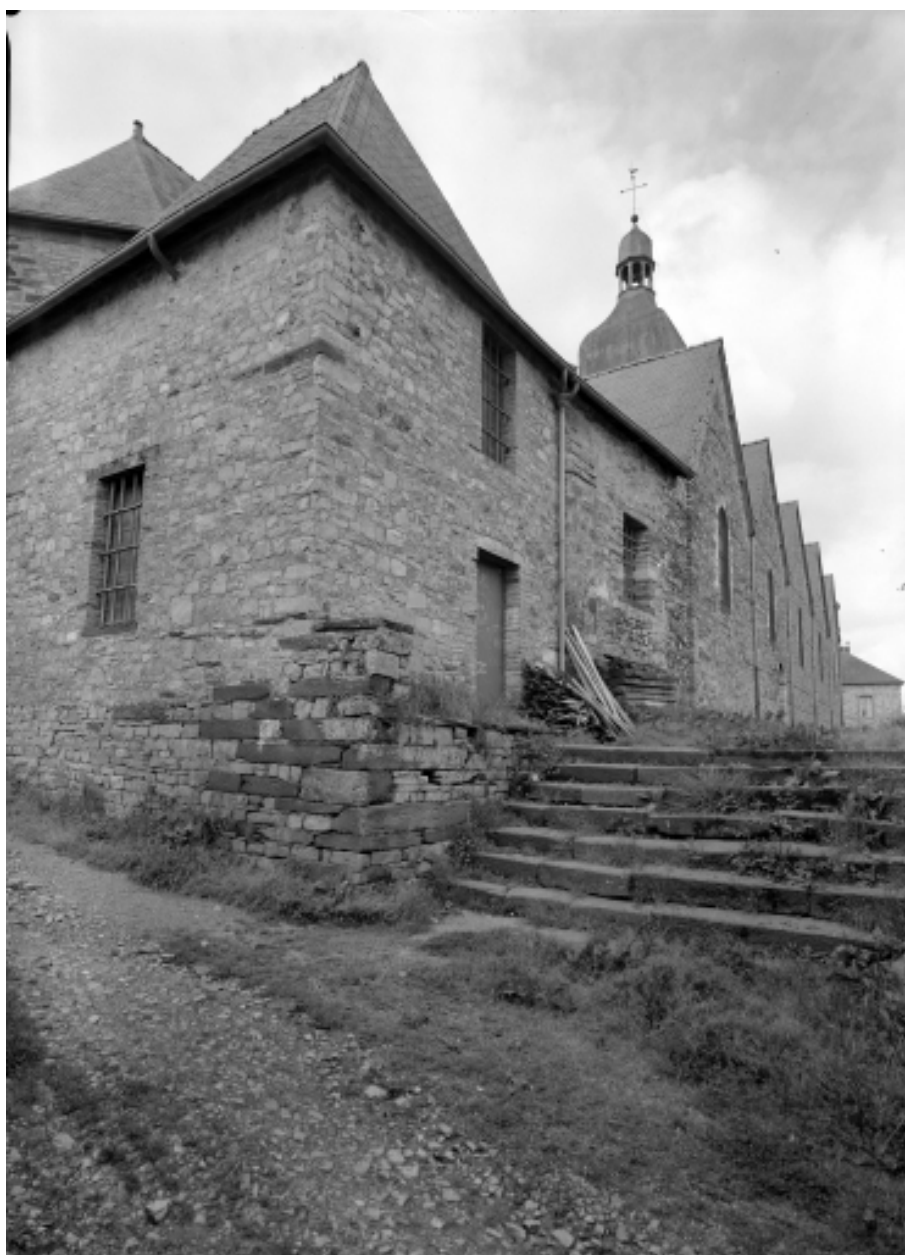
Elévation nord-est : vue générale
