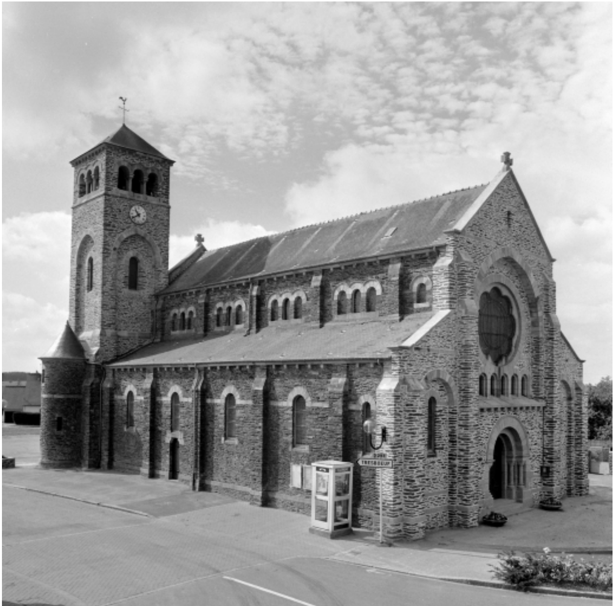
Elévation nord-ouest : vue générale
