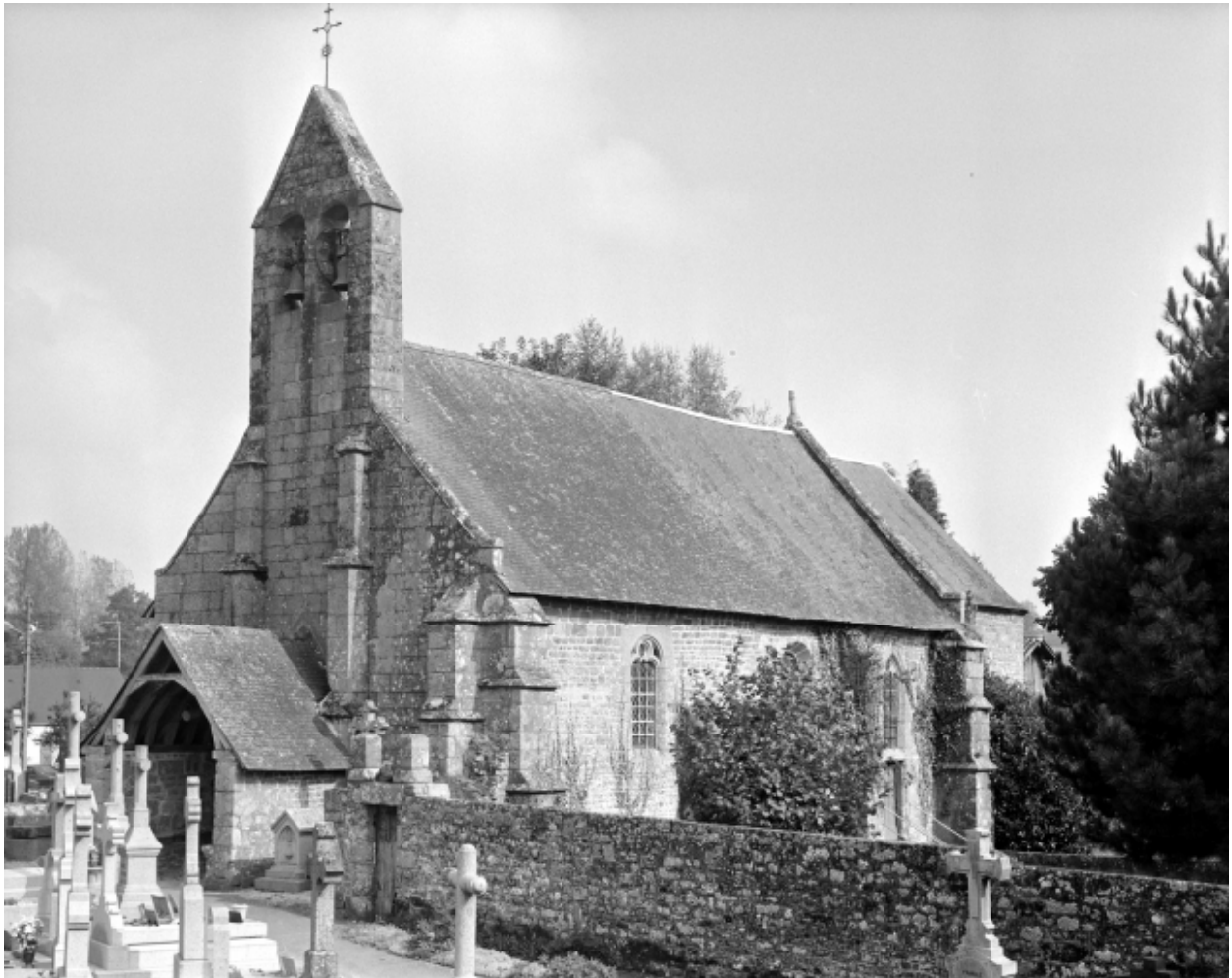
Elévation Sud-Ouest : vue générale
