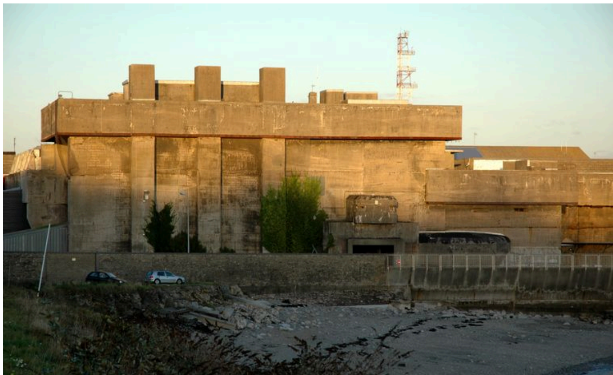
Vue de la base de sous-marins : détail du front sud-ouest
