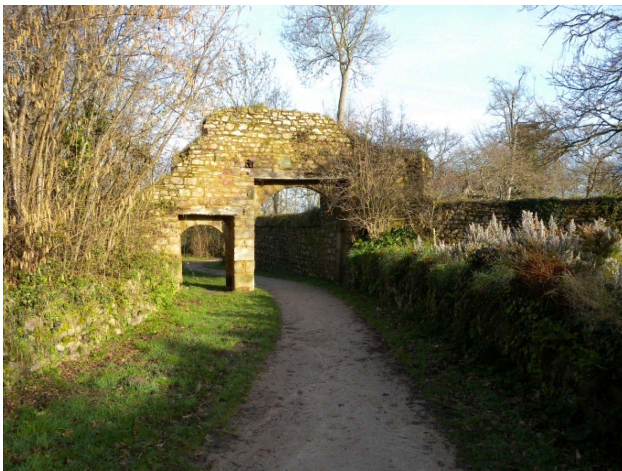
Vue des portes en plein cintre, façade Nord
