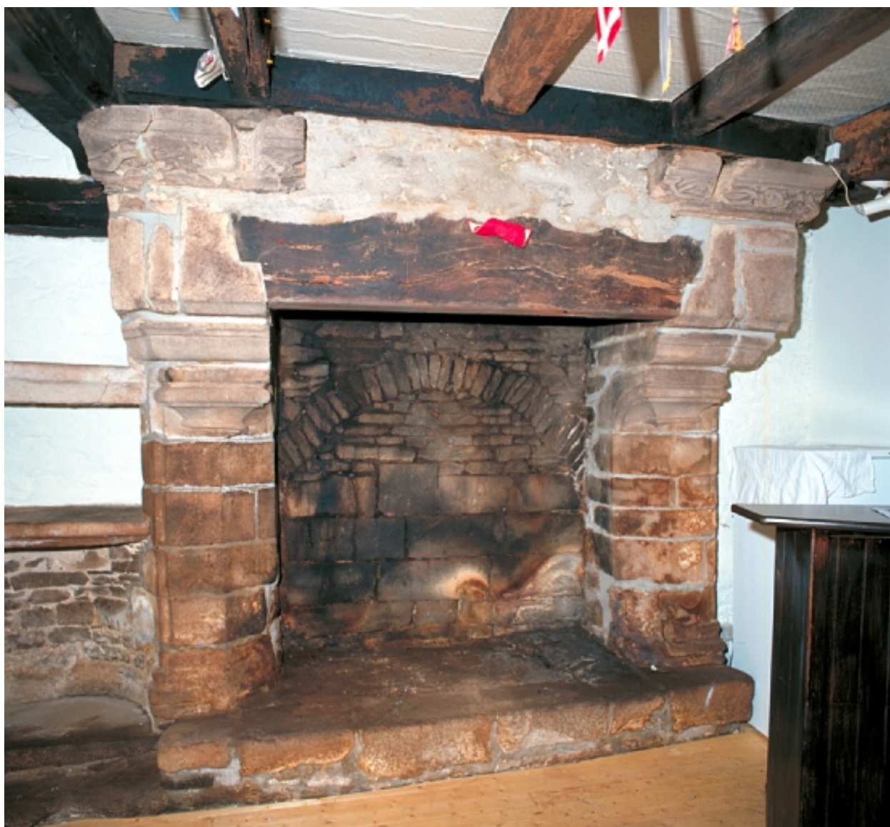
Cheminée du rez-de-chaussée intégrée au mur sud (2 rue Ellé)
