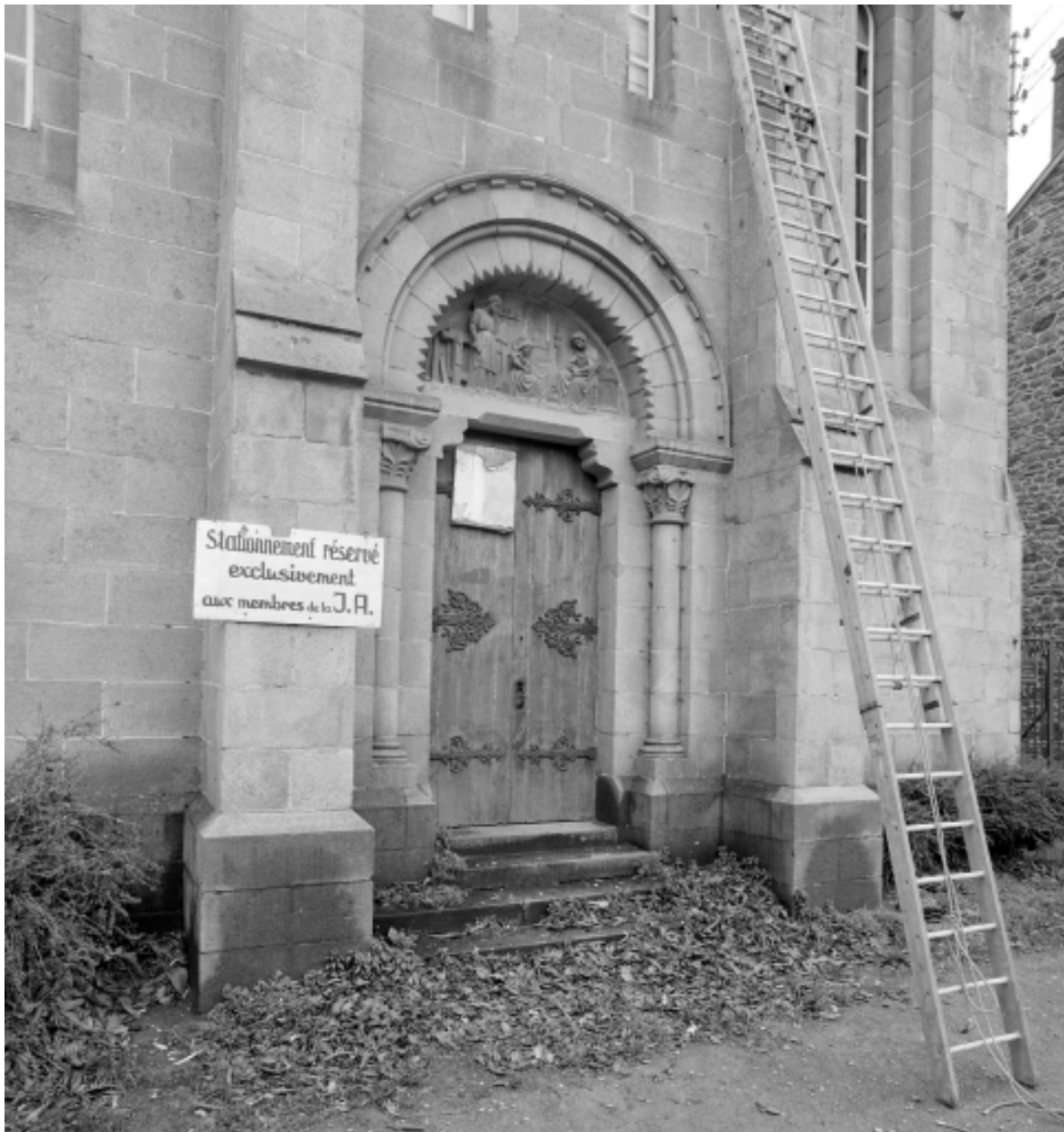
Elévation Ouest, porte : vue générale
