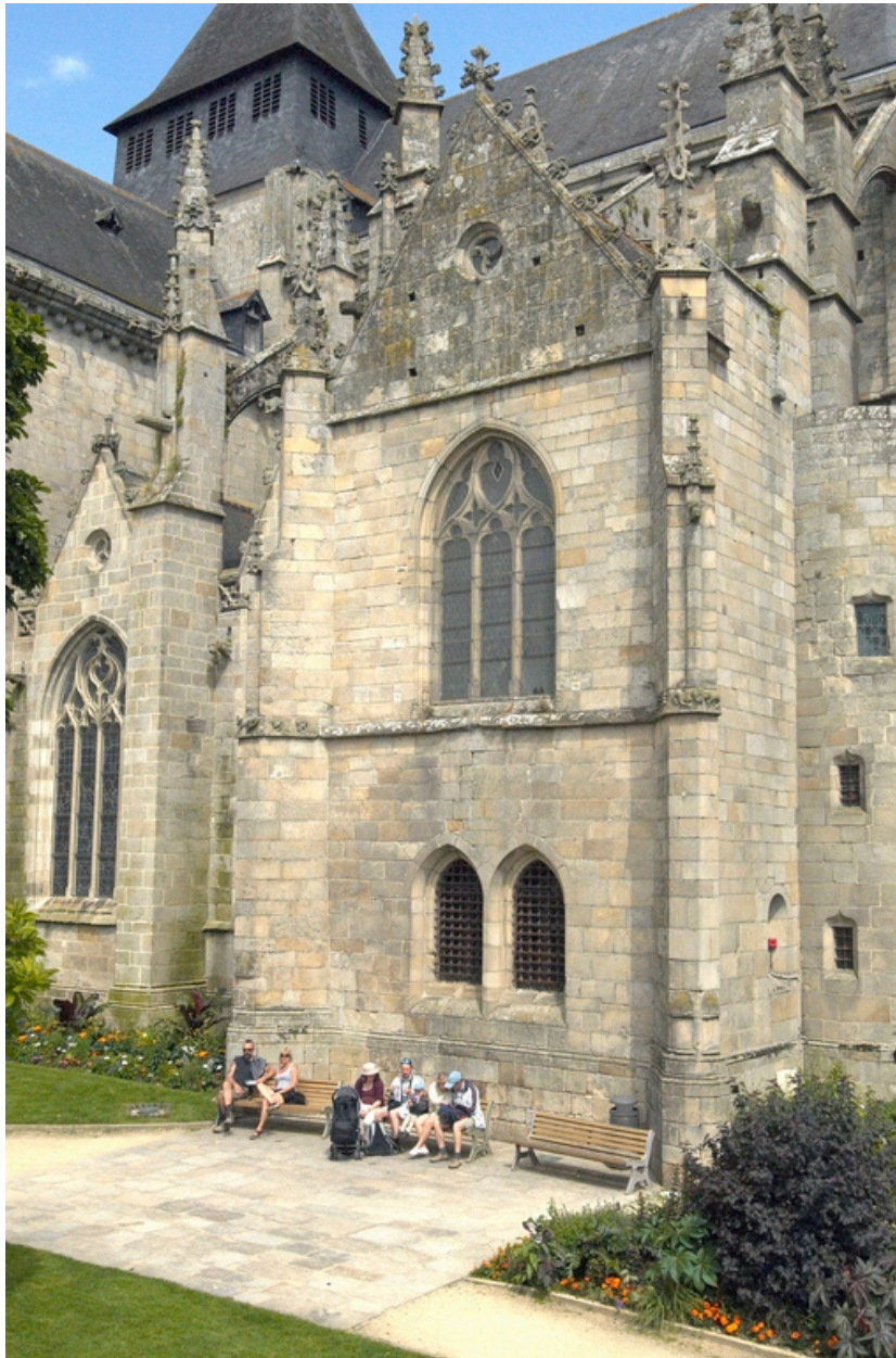
Sacristie et trésorerie, vue générale
