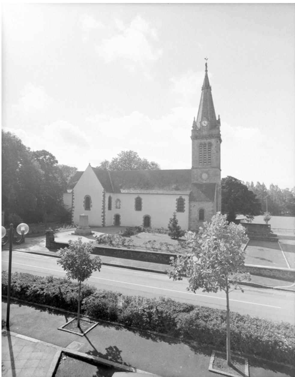
Elévation Nord : vue générale
