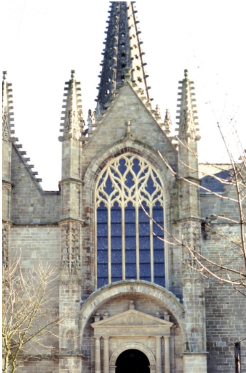
Elévation ouest : vue générale.
