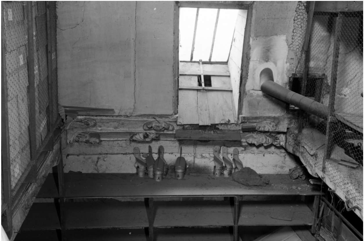
Première travée sud, sablière.
