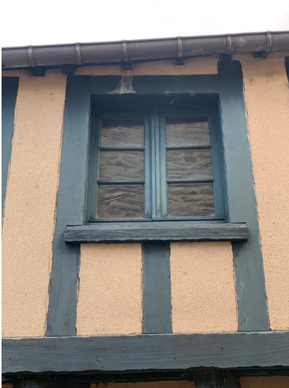
Elévation ouest, partie sud, fenêtre au rez-de-chaussée
