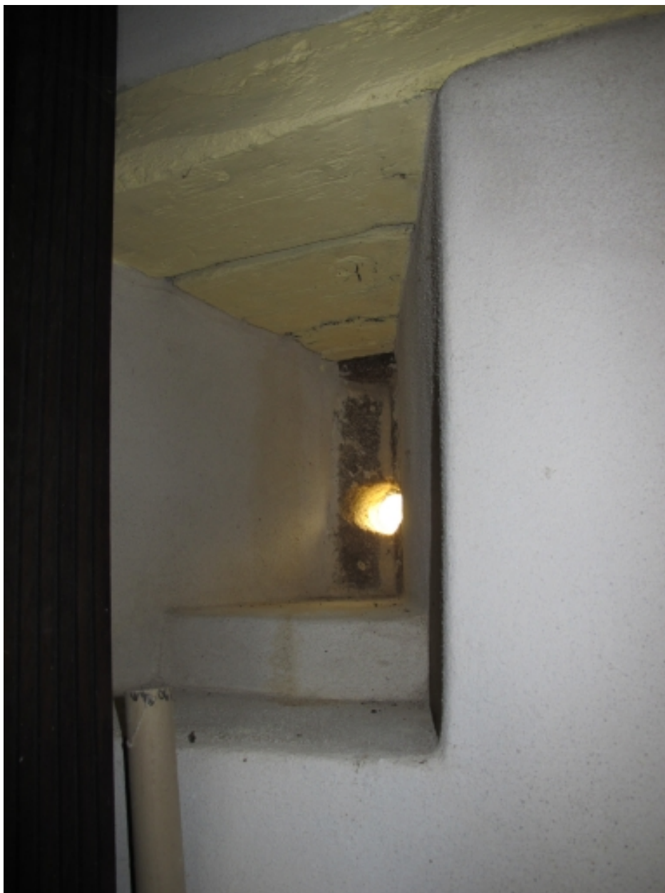
Meurtrière située dans le bâtiment sud-ouest
