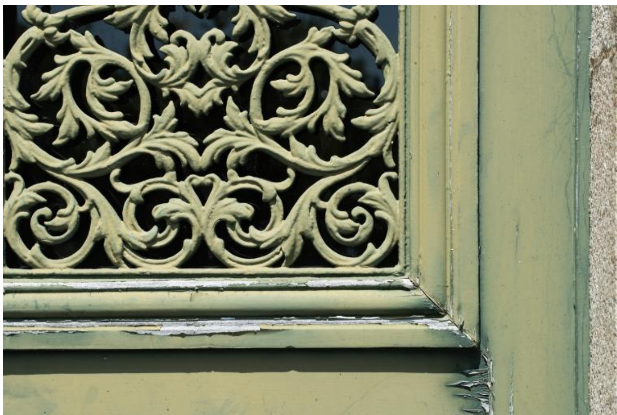
Détail de la porte d'entrée
