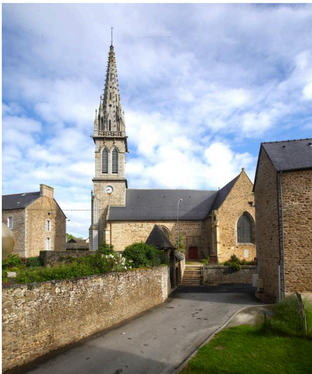
Vue générale : côté Sud-Ouest (rue du Porche)
