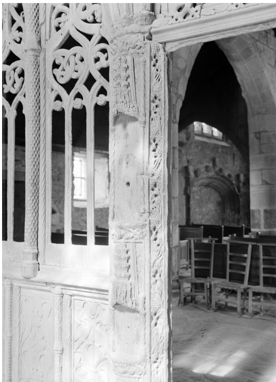
Jubé, face ouest : détail du poteau nord de la porte (niches à dais)
