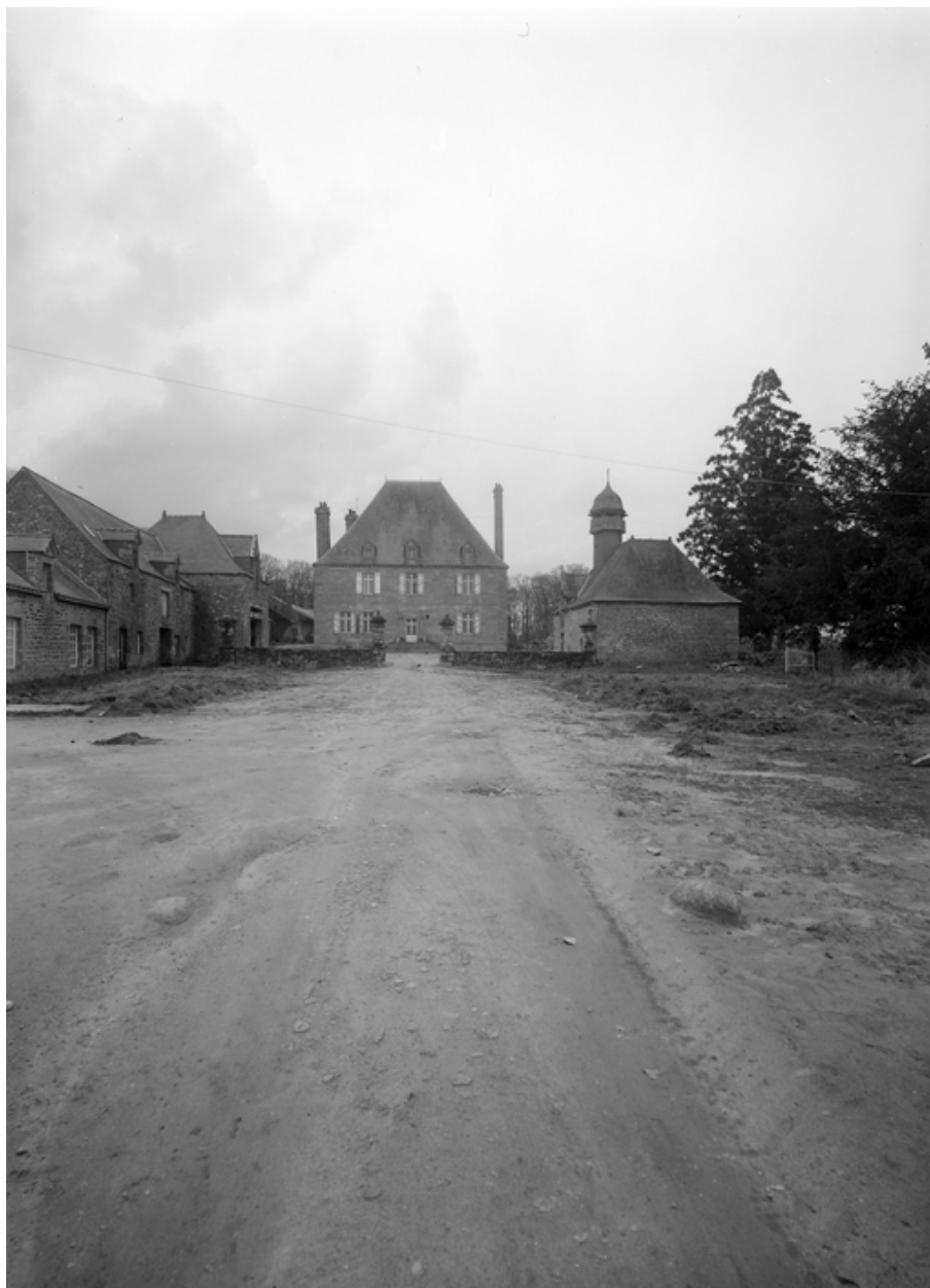
Façade sud : vue générale en 1977
